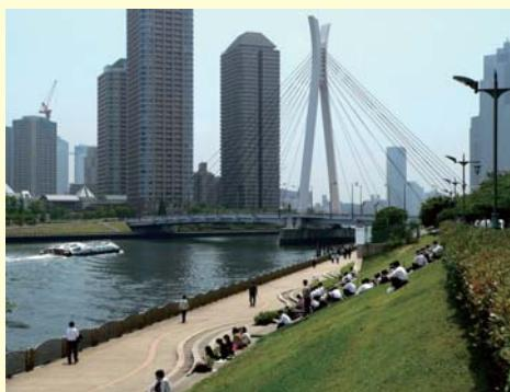
1960年代、工場排水と生活排水で汚れていた東京の隅田川は、下水道整備により水質が向上した。また、防災上の観点から垂直のコンクリートで固めた護岸であったが、スーパー堤防として、緩傾斜の土盛を行い、緑化することにより、市民の憩いの空間に生まれ変わった。
